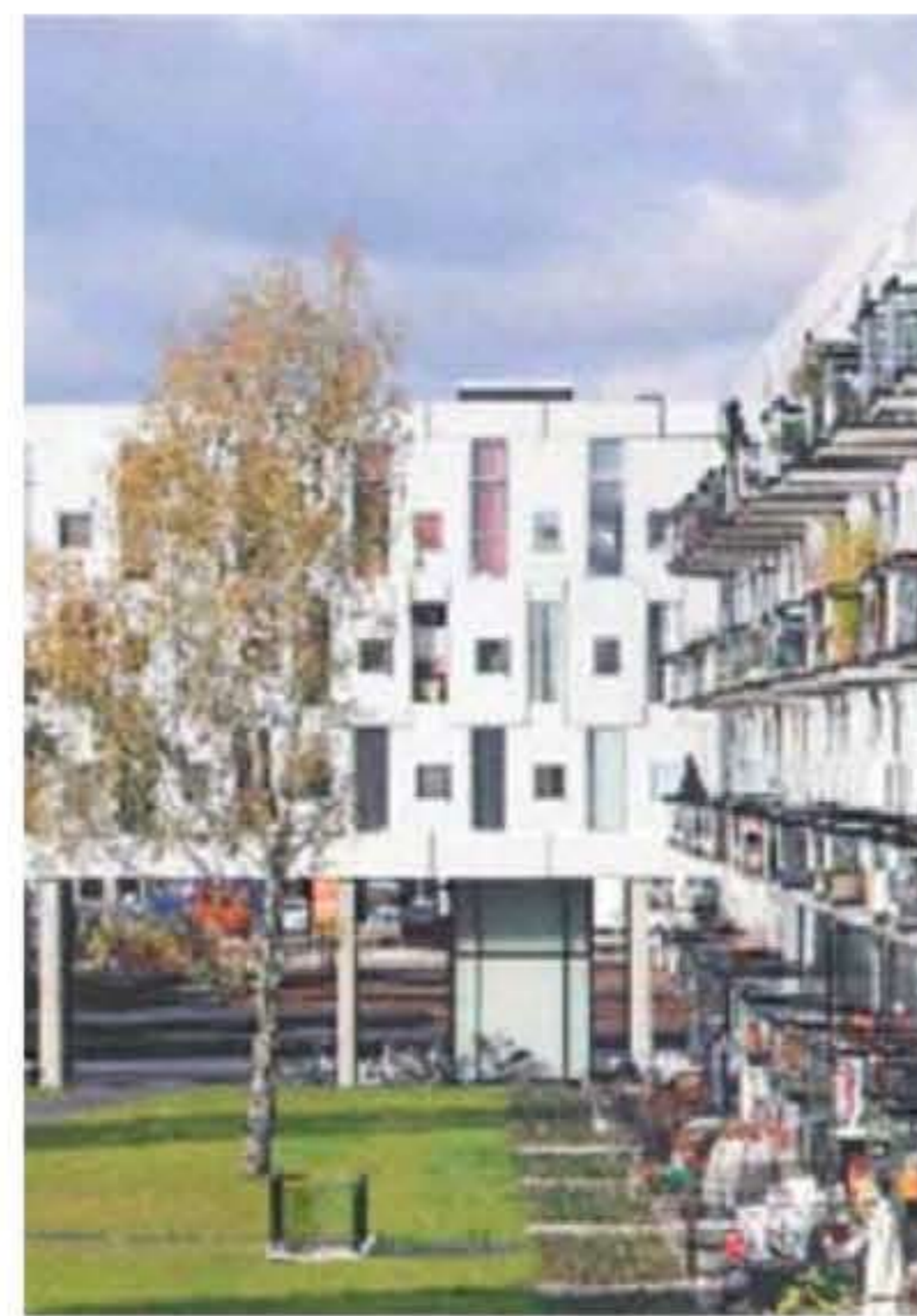
gjennomgang under huset til grøntareal
