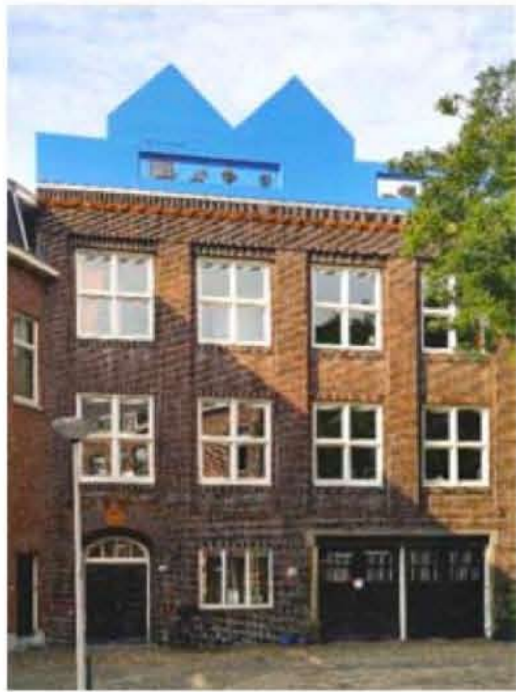
3 etg. i tegl med "noe oppå"
